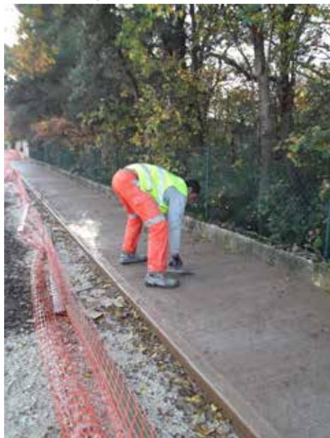
Ce revêtement a été spécialement étudié pour faciliter les déplacements en fauteuils roulants ou en poussettes. Il est plan, non glissant avec des pentes transversales ne dépassant pas 2% pour que le roulage soit fluide et la marche peu fatigante
